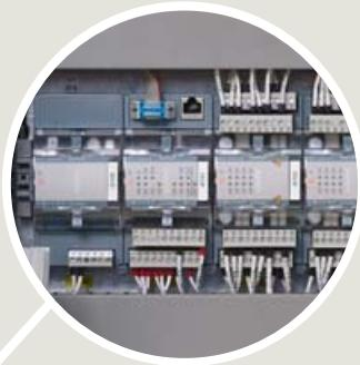
Прибор SICAM MIC встроен в отдельный электрошкаф в местной распределительной подстанции
