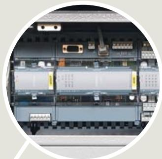
Прибор SICAM EMIC встроен в электрошкаф низкого напряжения на распределительном устройстве 8DJH
